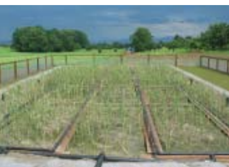
Frisch gesetzte Pflanzenkläranlage
