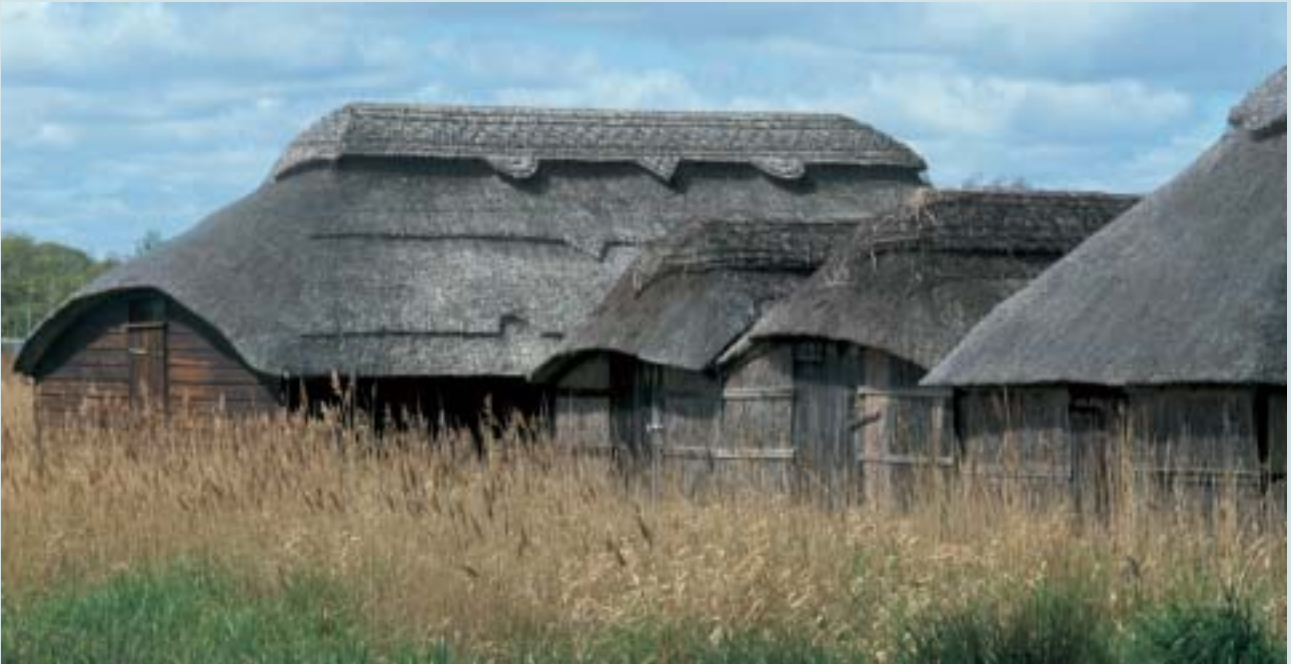
Riedgedeckte Bootshäuser in den Broads
