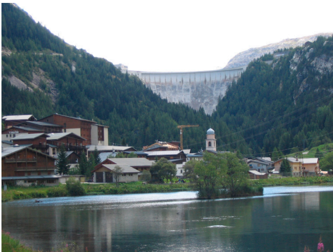
Tignes dam, Les Brevières, France. Photo: ©Heidi Megerle 2007
