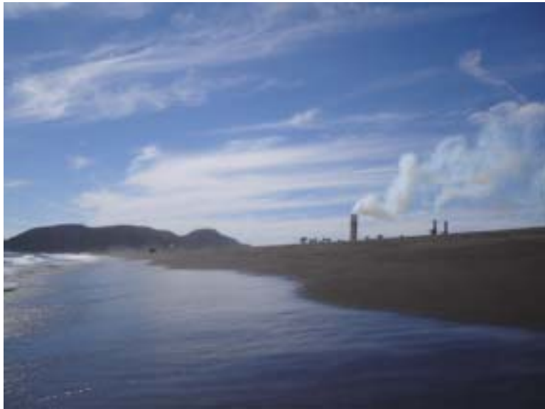
Planta Termoeléctrica de Manzanillo, Colima
